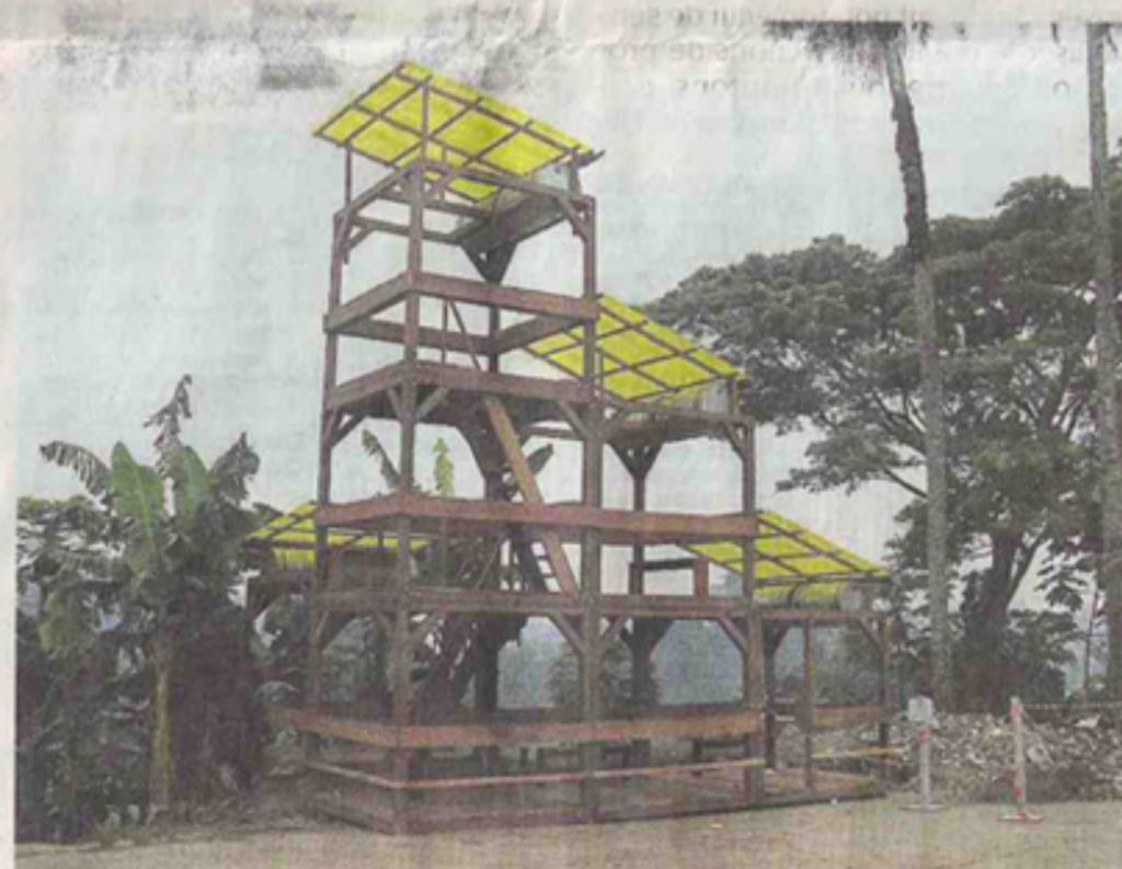
Fin de la seconde semaine : la structure est montée et les réservoirs d'eau installés.
